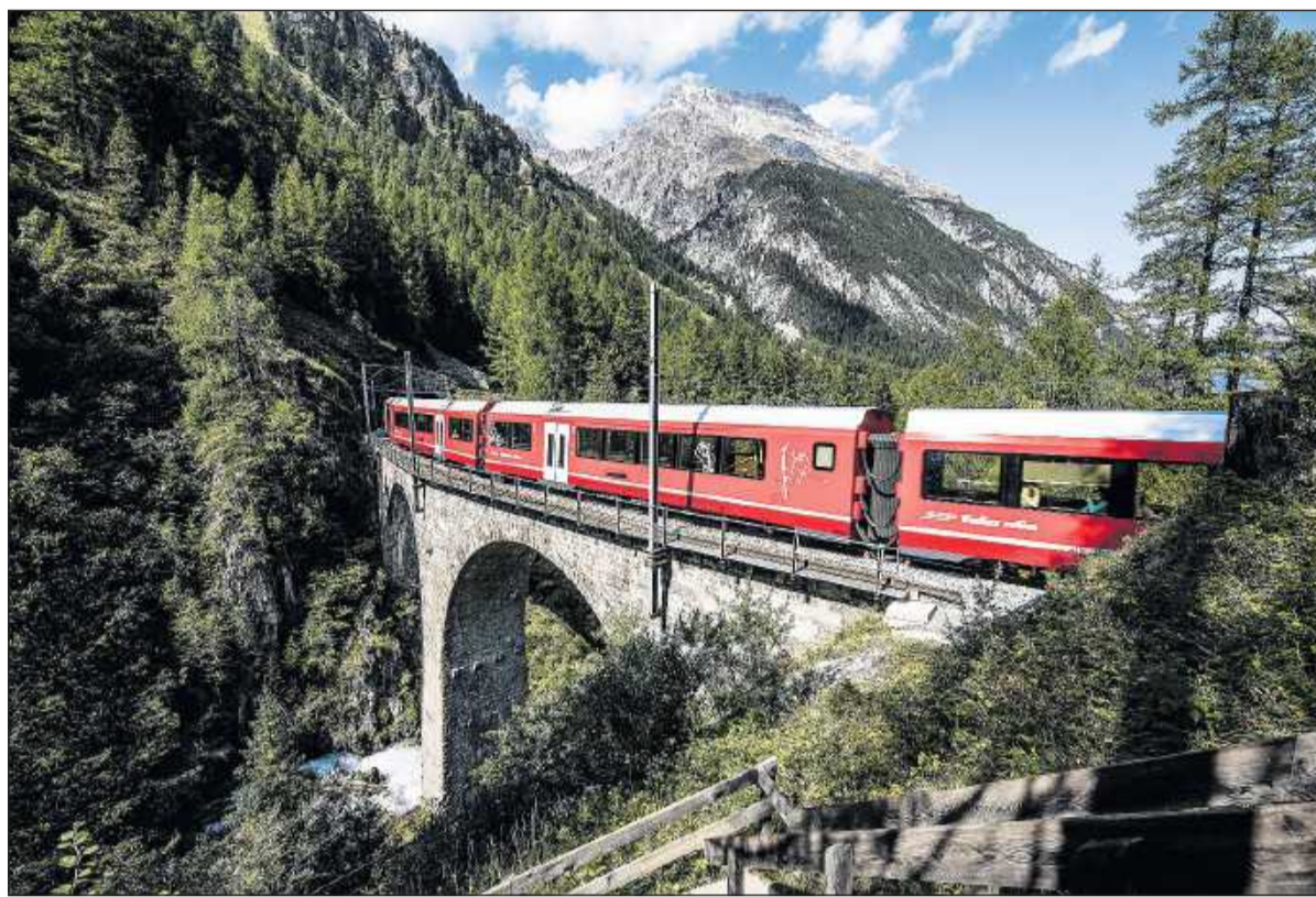
Die Albula-Linie führt über teilweise spektakuläre Viadukte durch eine faszinierende Landschaft von Graubündens Kantonshauptstadt Chur über Thusis nach St. Moritz.
